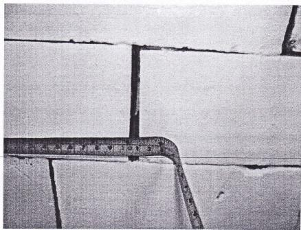
Figura 17. Grietas de espesor máximo de 8 mm
